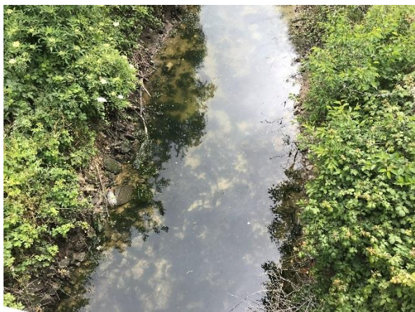
Berges du Riveau au niveau du confortement
