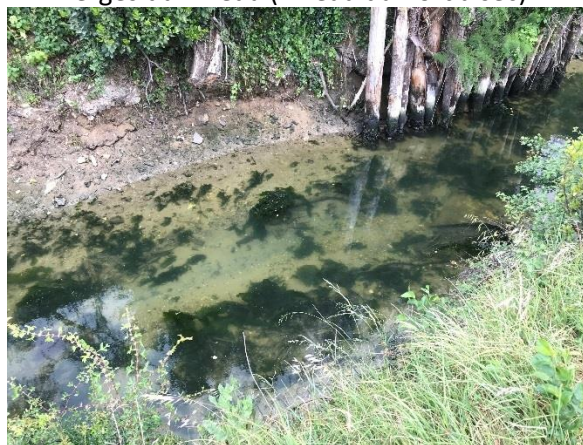
Fond du Riveau au niveau du confortement
