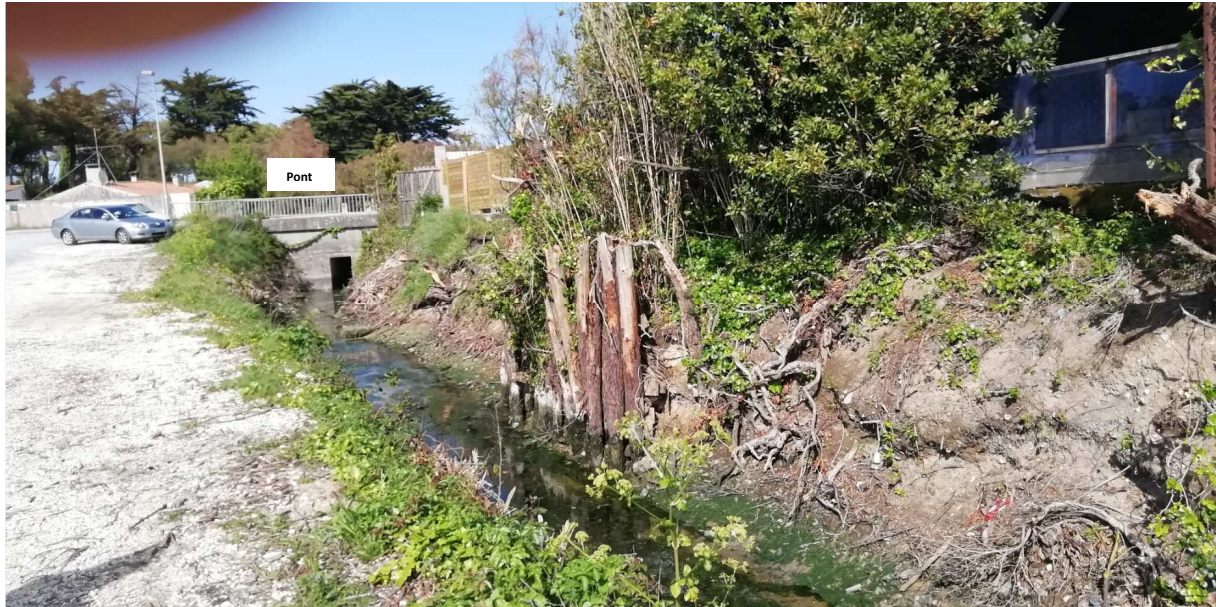
Figure 9 : Photo 3 - Illustration de la dégradation des berges du Riveau en rive droite – CC Oléron
