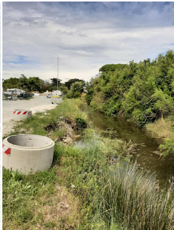
Aggravation de l'affaissement - Juin 2021
