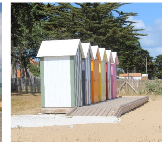
Lot 4 : Cabines de plages accès n°9
