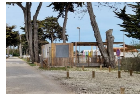
Places de Stationnement PMR à proximité de l'accès à la plage
