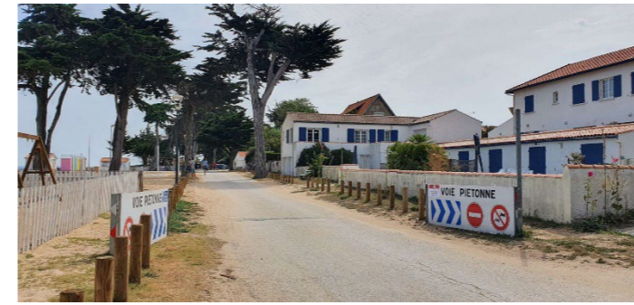
Barrières au niveau de la rue des Tamaris
