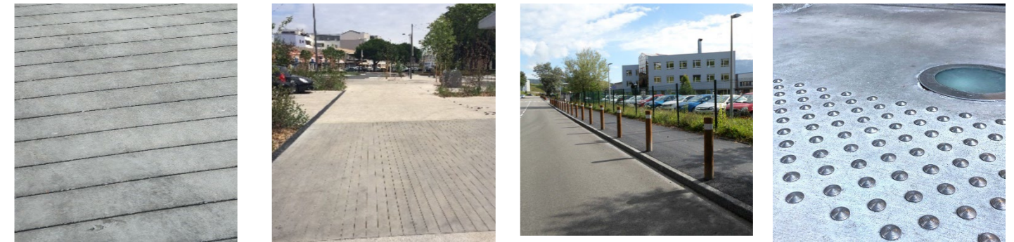
Béton poreux scié offrant une esthétique proche du platelage bois
