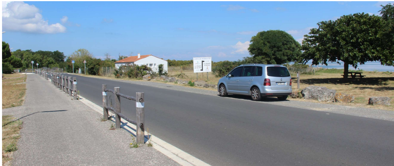
Figure 3 : Exemple de voie en site propre en accotement – Le Château d'Oléron (Source : CDCIO)
