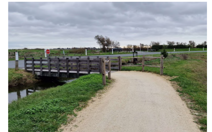
Figure 8 : Exemple de voie en sablé calcaire – La Brée-les-Bains (Source : CDCIO)
