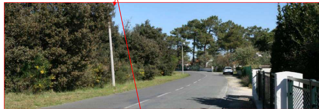
Vue du tronçon Sud de la section 58
