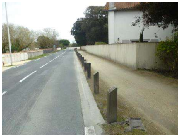
Piste PVII en site propre - Protégée par des potelets bois Route de la Perroche
