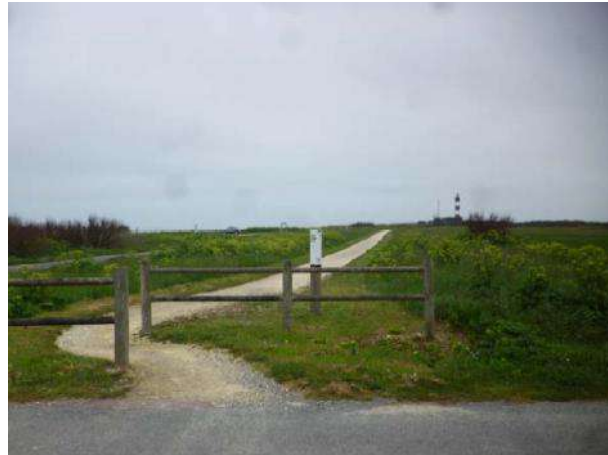
Piste PVII en site propre, réalisée en sable calcaire au phare de Chassiron
