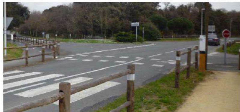
Figure 5 : Traversée matérialisée par un marquage au sol – Source : SCE
