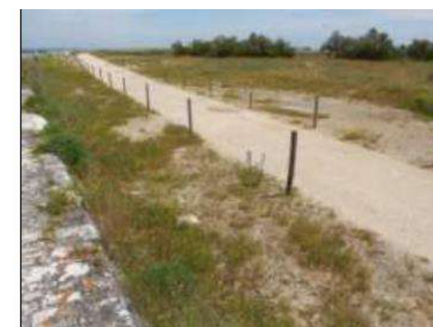
Figure 27 : Clôture longeant le perré du chenal maritime de Boyardville
