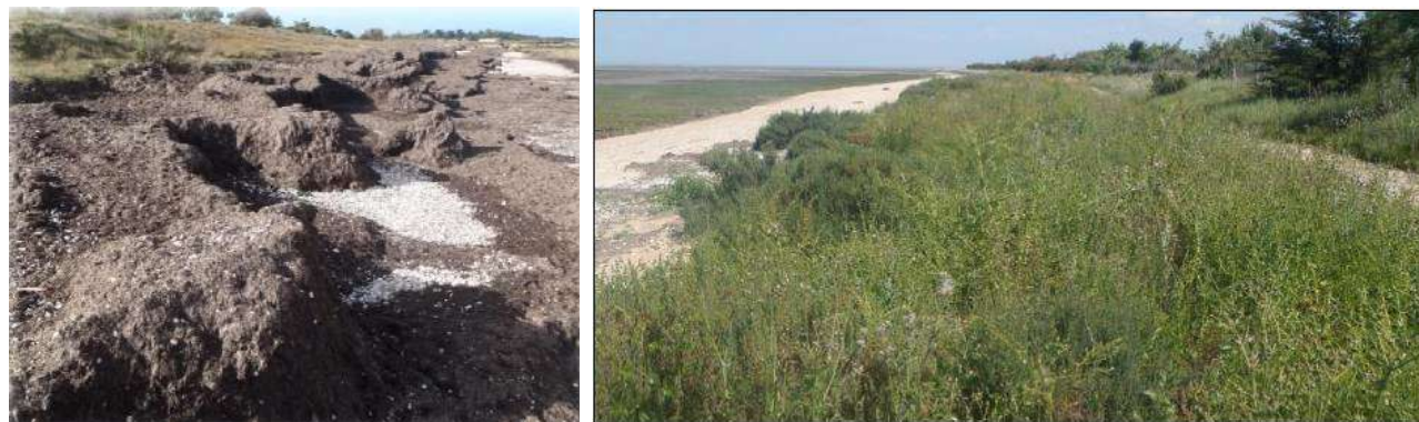
Figure 22 : Erosion dans le secteur du Moulin à la côte (gauche) – Dune couvert par une végétation buissonnante (droite) - Source : RNN Moëze-Oléron
