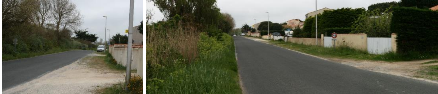
Figure 47 : vue de la traversée de Les Huttes : à droite accotement en zone humide, à gauche, absence de zone humide
