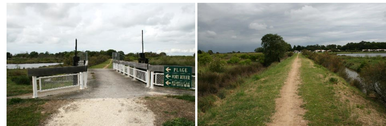
Figure 45 : vues de la portion de la section 74 au Sud du milieu dunaire vers le marais sur sentier existant
