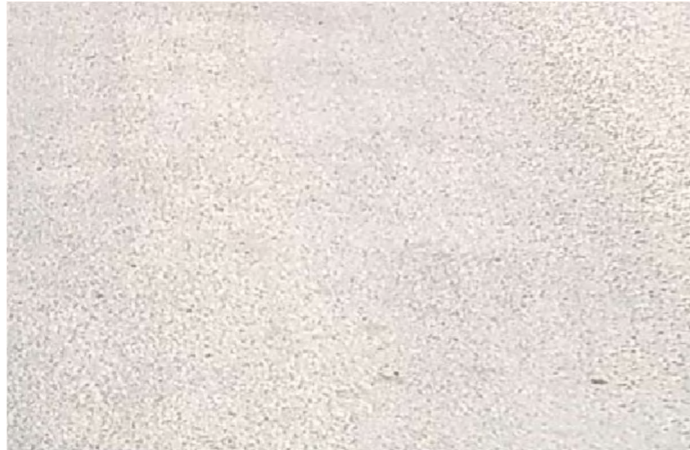
Figure 9 : Revêtement bicouche calcaire (Source : CDCIO)
