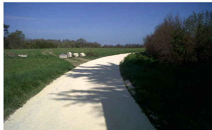
Figure 2 : Exemple de piste en site partagé modes doux Itinéraire Dolus d'Oléron – Les Allards
