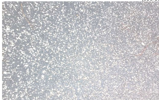
Figure 4 : Revêtement grave émulsion calcaire (Source : Etude paysagère PVIII)
