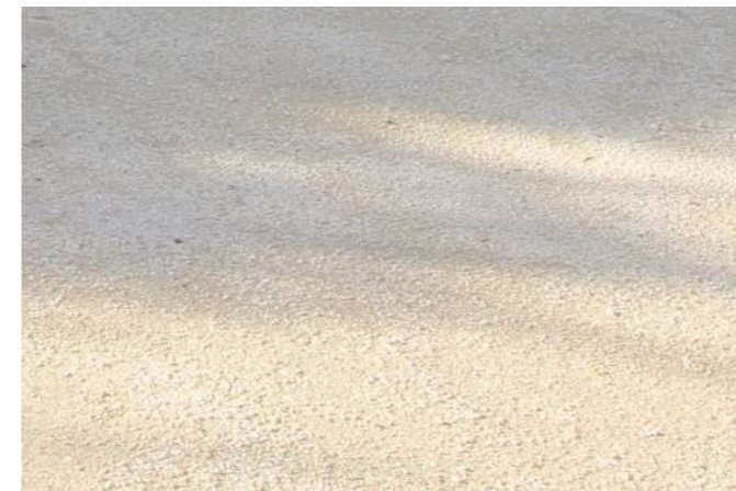
Figure 7 : Revêtement sablé calcaire (Source : CDCIO)
