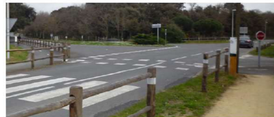
Figure 14 : Traversée matérialisée par un marquage au sol (Source : Etude paysagère PVIII)
