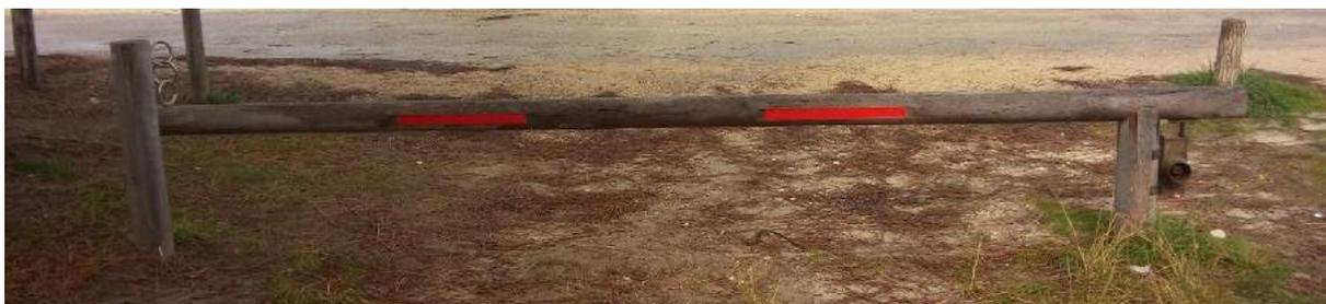
*Barrière pivotante avec réflecteurs anti-collision*
