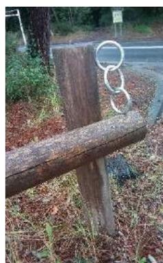
*2<sup>ème</sup> poteau avec découpe de l'empreinte de la lisse et système de fermeture*
