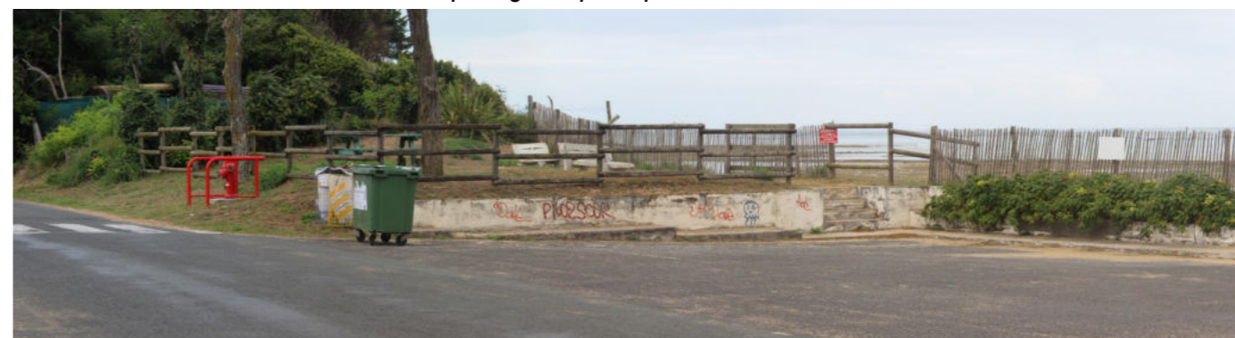
5 – Vue du parking depuis la rue de Douhet
