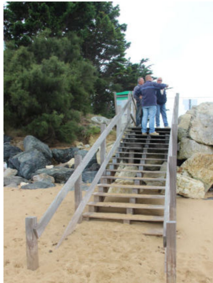
Escalier bois existant (Source : CDCIO)
