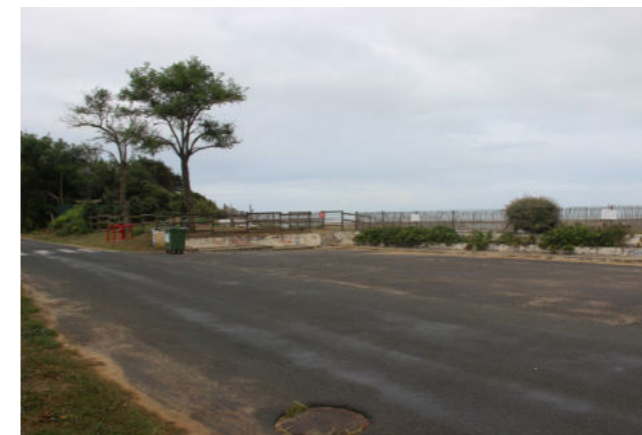
Emprise du parking surdimensionnée formant une plateforme en enrobé peu valorisante (Source : Atelier du périscope)
