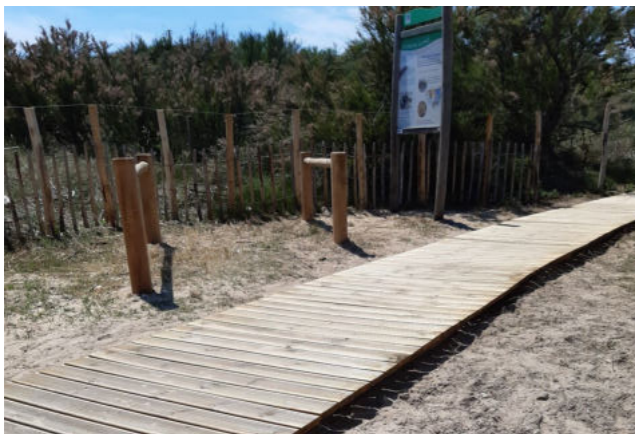
Platelage bois posé sur sable (Source : CDCIO)
