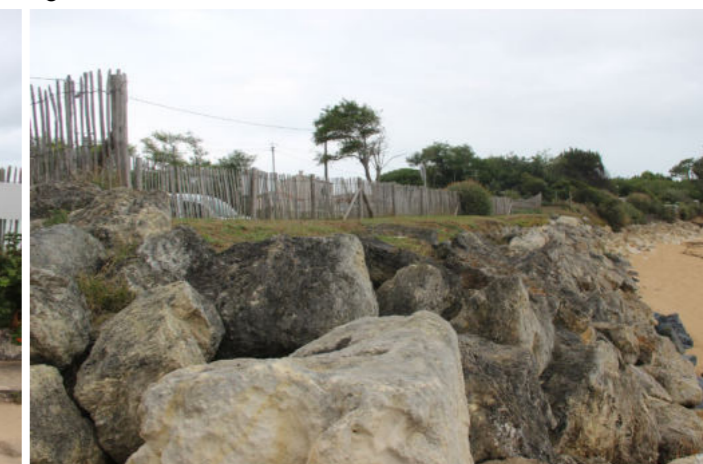
3 – Empierrement protégeant la dune de l'érosion côté océan
