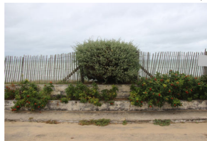
2 – Muret de soutènement tenant la dune côté parking
