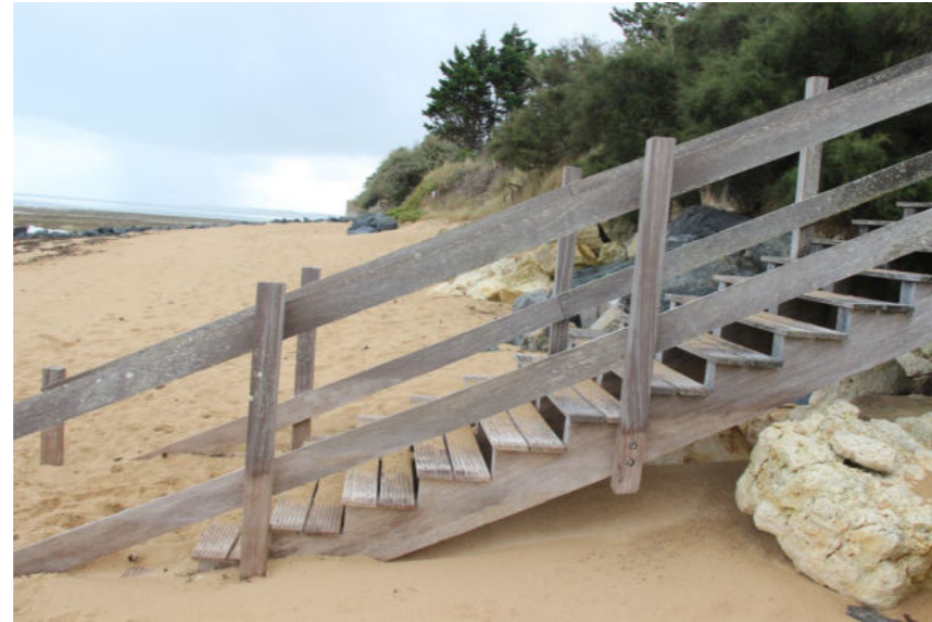
Escalier bois existant (Source : Atelier du périscope)
