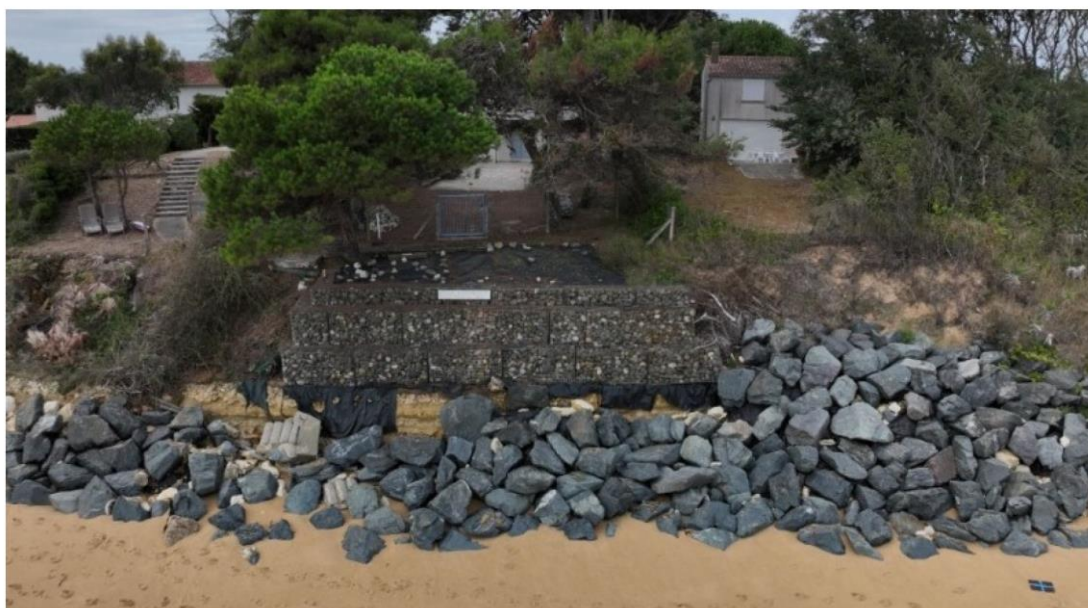
Figure 23 : Empilement de gabions existant devant la propriété Aigoin sur le secteur ARA (photos obliques Neoseastem, 2025)
