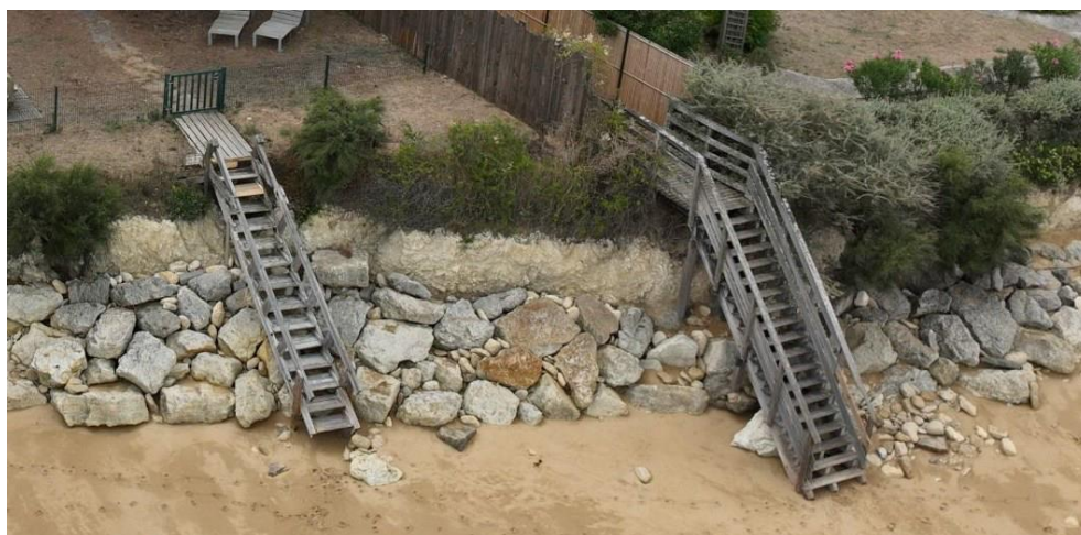
Figure 26 : Exemple d'accès en bois existant sur ARAB Sud (Neoseastem, 2026)
