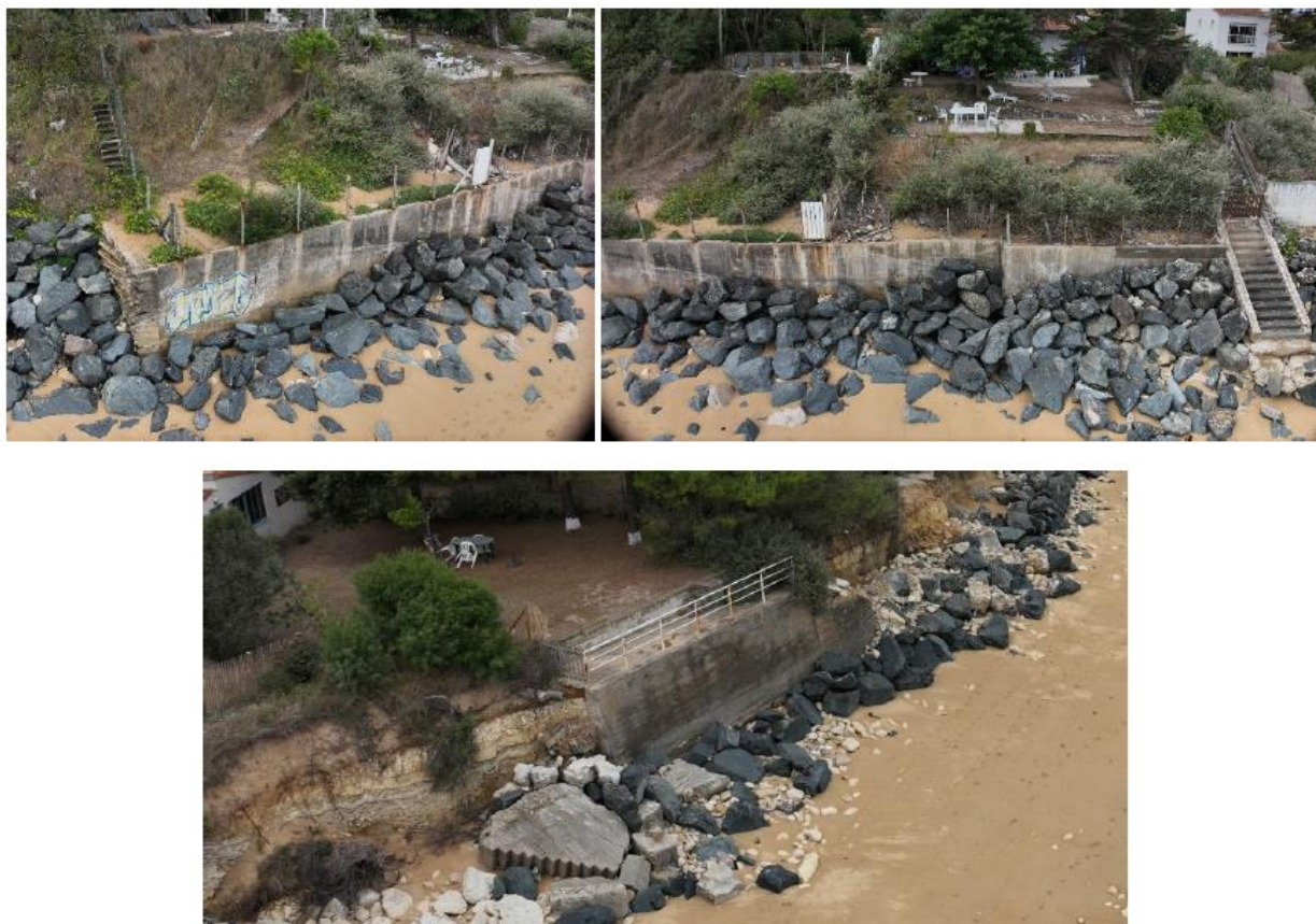
Figure 22 : Murs existants sur le secteur ARA (en haut) et ARAB Sud (en bas) (photos obliques Neoseastem, 2025)
