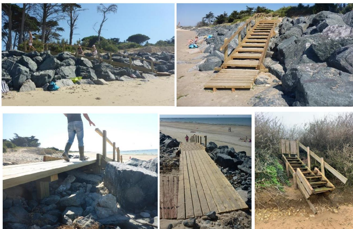
Figure 28 : Exemple d'escalier en bois avec plateforme en crête sur enrochements et d'escalier rétractable (Neoseastem, APS, 2026)
