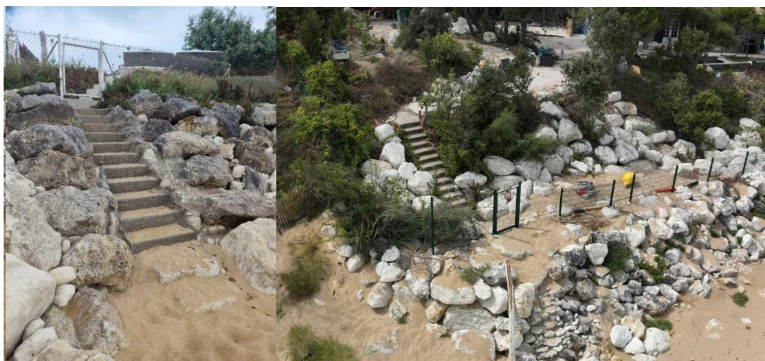
Figure 27 : Escalier Bel/Weber à adapter (G) et escalier Weber à prolonger avec un escalier en bois (D) (Neoseastem, 2026)
