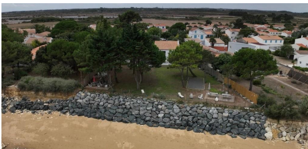
Figure 24 : Talus en enrochements refait à neuf en 2024 secteur ARAB Sud (photos obliques Neoseastem, 2025)
