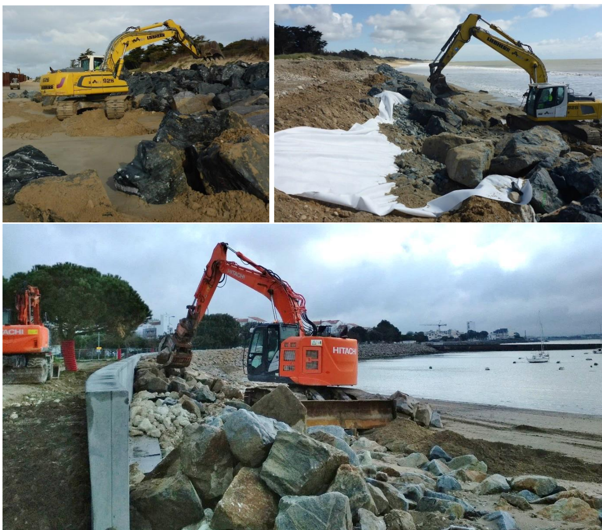
Figure 38 : Exemple de mise en œuvre du talus en enrochements avec une pelle munie d'un godet à la Couarde-sur-Mer, Ile de Ré (en haut) ; mise en œuvre du talus en enrochements avec une pelle munie d'un grappin dans la baie de Port- Neuf, La Rochelle (en bas) (Neoseastem, APS, 2026)
