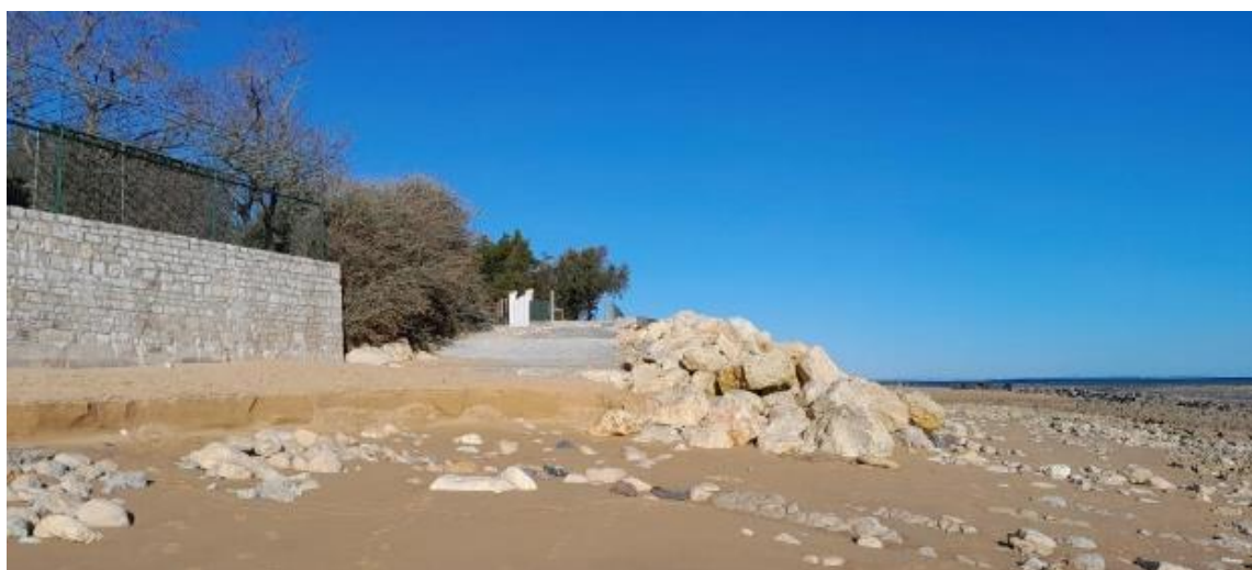
Figure 43 : Photographies de la rampe d'accès des Boulassiers – Secteur ARPPN
